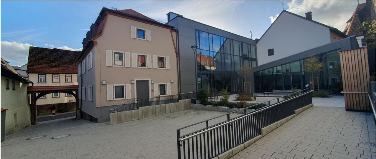
Blick in den Innenhof mit Bürgersaal
